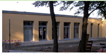
Neuer Kindergarten im ehemaligen Verwaltungsgebäude
