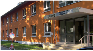
Neugestaltetes Haus der Begegnung
